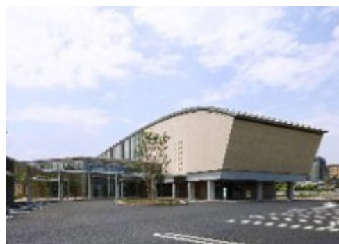
障害者就業・生活支援センターエブリィが入る高崎市総合福祉センター
