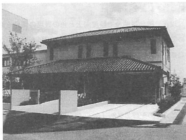
(a) 全景（左手のリハとは渡り廊下で接続）
