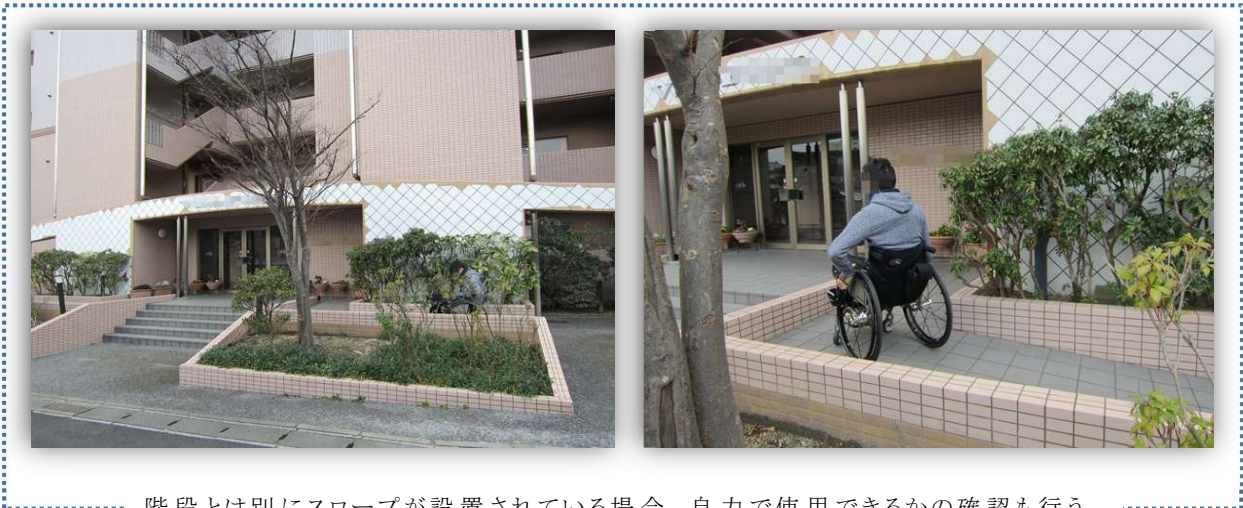
階段とは別にスロープが設置されている場合、自力で利用できるかの確認も行う
