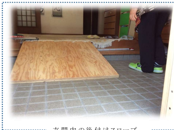
玄関内の後付けスロープ
