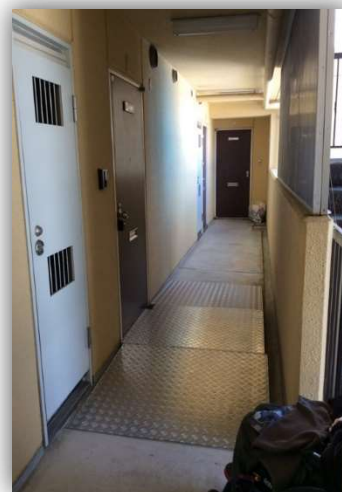
共用場所の段差解消
