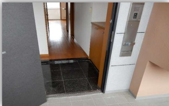
玄関段差や車椅子の取り回しを確認
