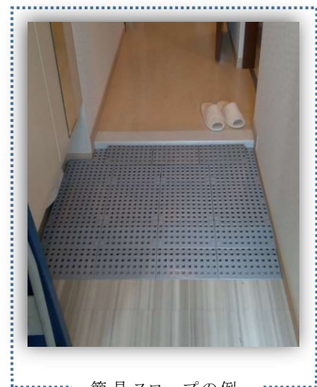
簡易スロープの例
