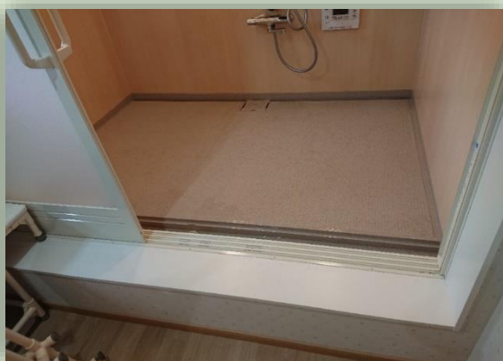
浴室は床をかさ上げして、イレクター台を設置（左：設置前 右：設置後）
