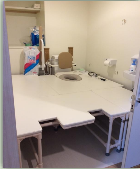
既存のトイレ全面をイレクターで高床仕様にした。動作に支障がある手すりを撤去。背もたれを新規設置。(左:既存 右:改修後)
