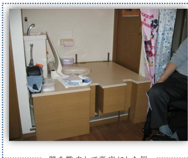
壁を撤去して高床にした例
