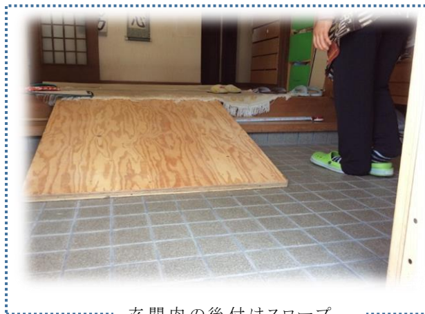
玄関内の後付けスロープ
