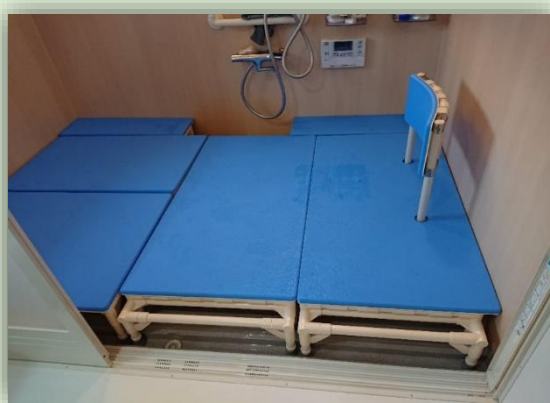
浴室は床をかさ上げして、イレクター台を設置（左：設置前 右：設置後）
