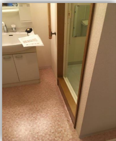
..... ユニットの段差前より高床台を設置した例 .....
