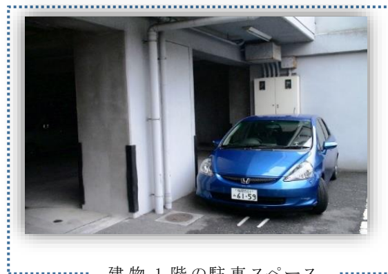
建物 1 階の駐車スペース
