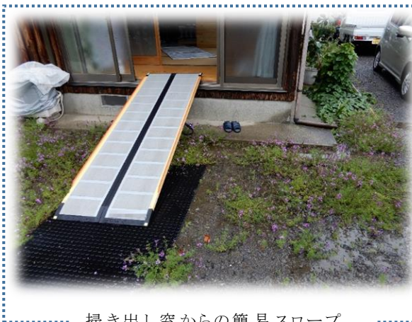
掃き出し窓からの簡易スロープ
