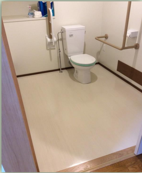
既存のトイレ全面をイレクターで高床仕様にした。動作に支障がある手すりを撤去。背もたれを新規設置。(左:既存 右:改修後)
