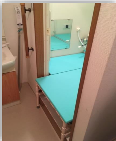
..... ユニットの段差前より高床台を設置した例 .....
