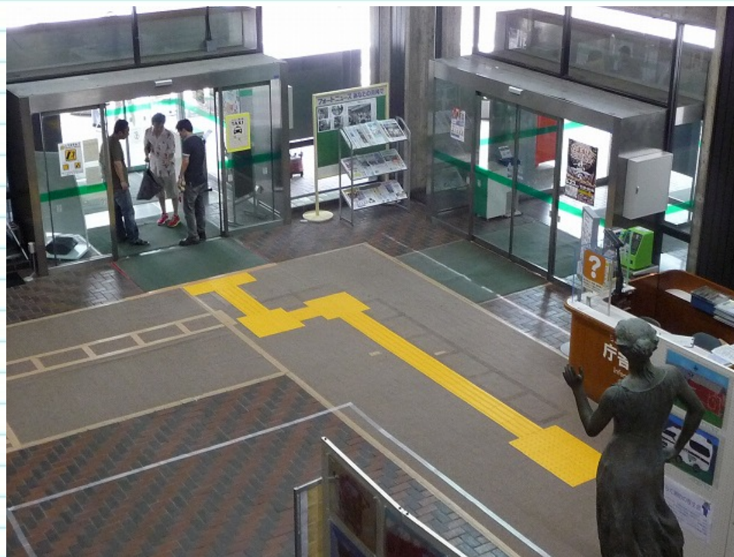
エラストマー（軟質性樹脂）タイプ 視覚障がい者用誘導シートの公共施設内施工例 【世田谷区役所内】
