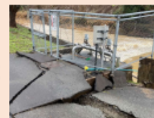
水道の復旧 (被災した浄水場)
