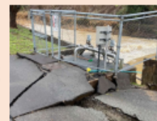
水道の復旧 (被災した浄水場)
