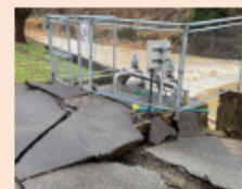
水道の復旧 (被災した浄水場)
