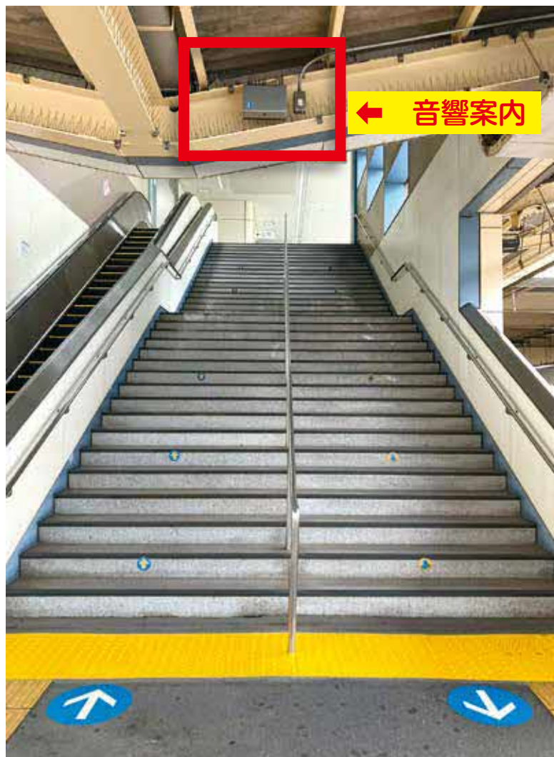
写真1 階段と音響案内
